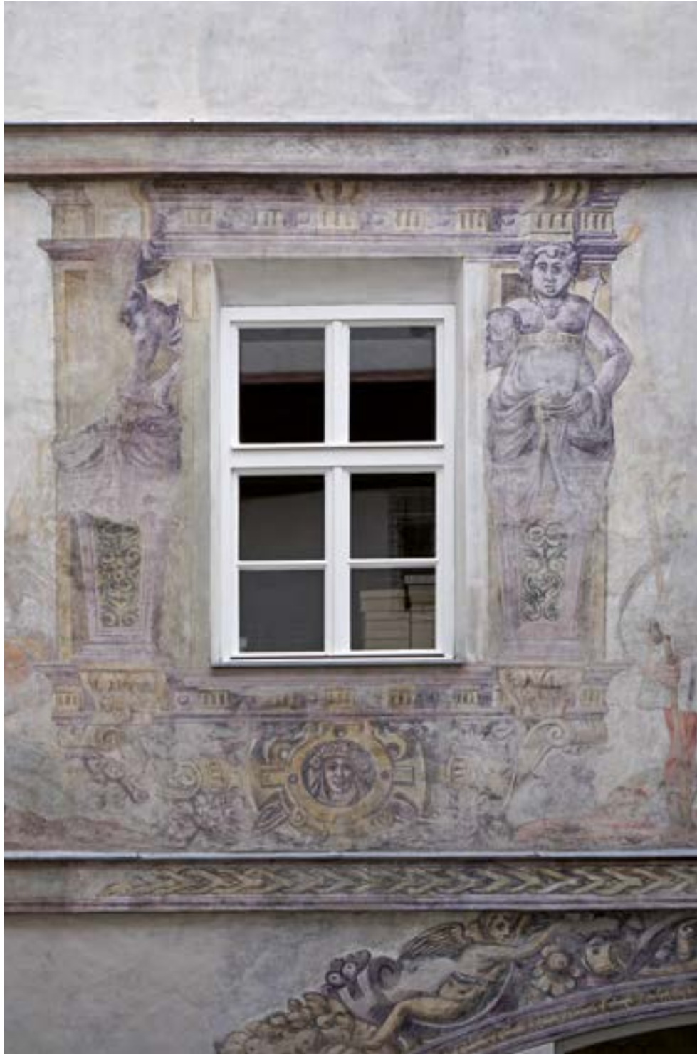
Damenstift, Innenhof, Detail Südwand nach Restaurierung
